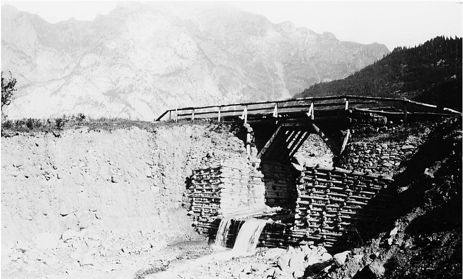
Il ponte di legno sul Moscardo, costruito con la tecnica in uso a fine Ottocento.
