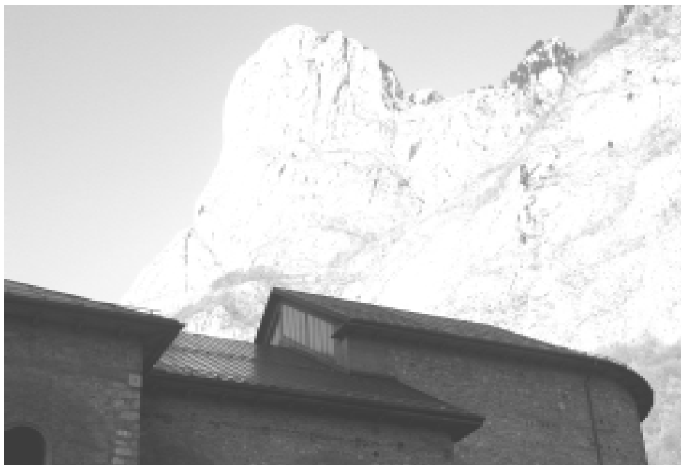
Il nuovo tetto della Chiesa di Cristo Re
